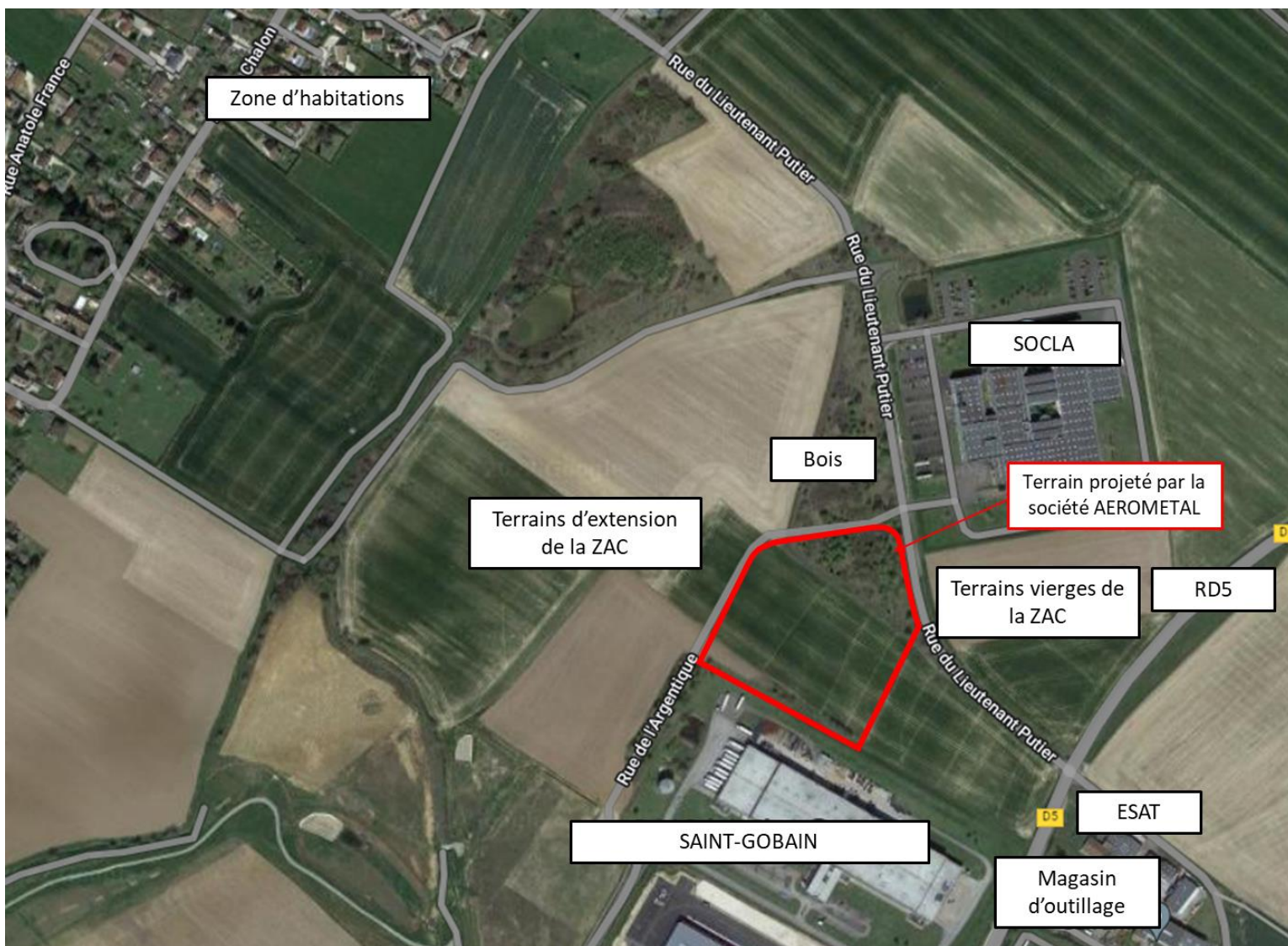
Figure 5 : Vue aérienne du site du projet
